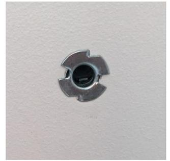
Dans les trous pré-percés, fixer les chevilles « molly » à placo dans le mur à l'aide d'une pince spéciale pour chevilles à placo. Si votre mur n'est pas en placo, adaptez les vis en fonction du support.
