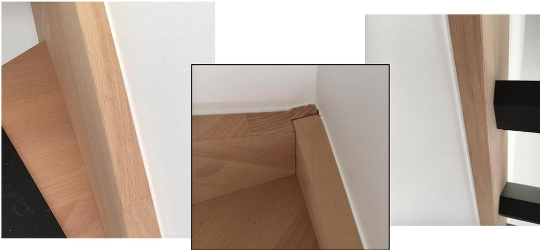
Finition : faire un joint au mastic acrylique blanc sur tous les angles en contact avec les murs. (Au dessus et en dessous des limons fixés aux murs).
