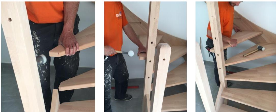
Mettre en place le poteau d'angle et insérer les marches dedans à l'aide du maillet ou d'une cale et un marteau. Le poteau doit parfaitement s'emboîter dans les marches de l'angle de l'escalier.
