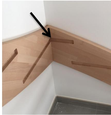
Mettre en place le quart tournant (limon contre le mur). Les deux entailles de la marche d'angle de l'escalier doivent être bien en face l'une de l'autre. Tracer un repère sur le mur au crayon lorsqu'il est bien en place.
