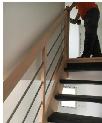
Visser le garde-corps au niveau de la main courante sur les poteaux de départ et d'arrivée de l'escalier dans les perçages prévus.
