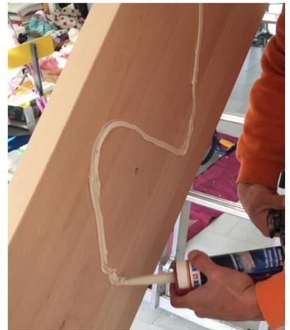
Encoller l'arrière du limon avec une colle néoprène en cartouche à l'aide d'un pistolet à colle manuel.
