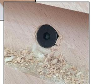
Répéter les opérations 4,5,6,7 et 8 pour le limon n°2 : placer le limon sur votre repère tracé au crayon précédemment puis le coller et le visser au mur avec des vis Ø10 et des chevilles molly.
