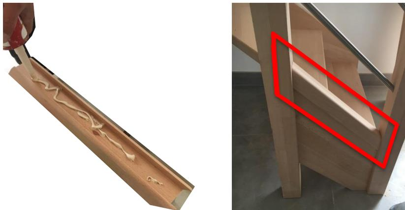
Encoller la lisse basse avec de la colle néoprène puis la coller sous les lisses en inox directement sur le limon intérieur.
