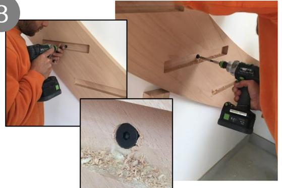
Visser toutes les vis dans les trous . Si besoin fraiser avec un foret à bois pour ne pas laisser dépasser la tête de vis.
