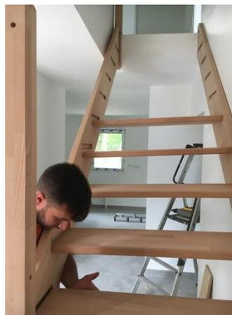
Mettre en appui le limon intérieur sur la trémie puis placer les marches dans leurs entailles afin de resserrer l'escalier.
