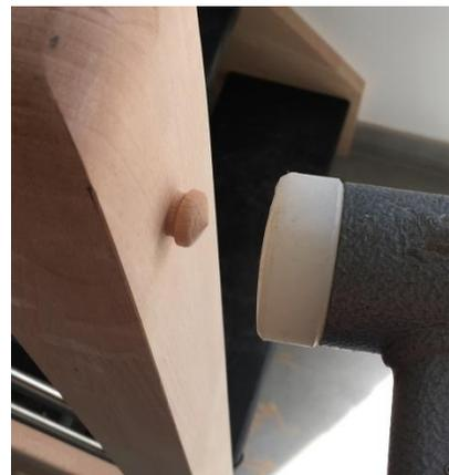
Comblent tous les trous de vissage avec les bouchons en bois. Enfoncer les bouchons avec un maillet.
