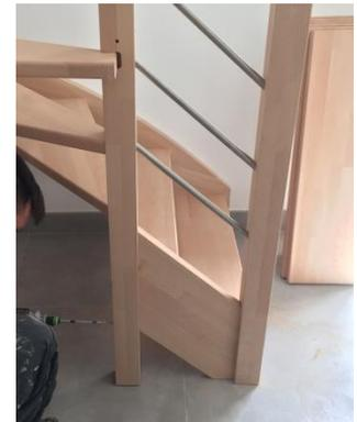
**Modèle contemporain /** Démontez ensuite le poteau de départ afin de mettre en place les lisses en inox du garde-corps. Une fois les 3 lisses installées, remettez le poteau de départ en place, puis revissez le poteau d'angle.
