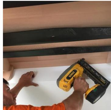
Sous l'arrivée de l'escalier pour cacher le jour entre la trémie et l'escalier, découper un champlat (baguette de finition fine en bois) à la bonne taille à l'aide d'une scie sauteuse puis clouer avec des pointes têtes d'hommes.
