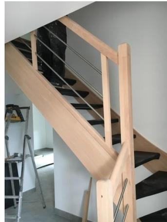
Installer le garde-corps rampant en appui sur le limon intérieur de l'escalier.
