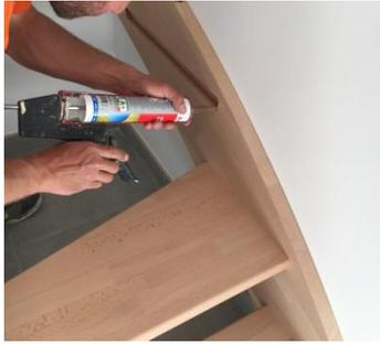
Mettre de la colle polyuréthane dans les entailles des marches à installer.
