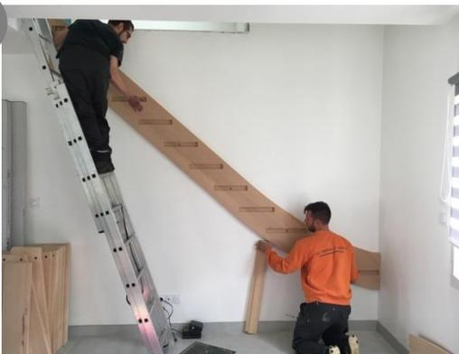
Coller le limon au mur en se replaçant sur les repères tracés au crayon.
