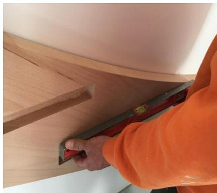
Ajuster le limon jusqu'à ce que les entailles de marches soient de niveau. Toujours vérifier le niveau avec un niveau à bulles. Une fois le limon bien en place, tracer un trait de repère sur le mur.
