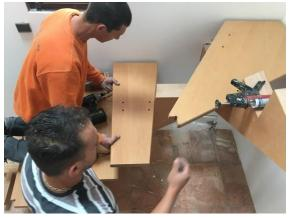
Continuer la mise en place des marches à partir de la marche n°2 une par une jusqu'au quart tournant (colle + vis  $\emptyset$ 5 x 70mm). NE PAS INSTALLER LA PREMIERE MARCHE.
