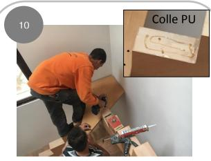
Collez à la colle polyuréthane puis vissez la marche d'angle dans le pré-trous avec les vis Ø5 x 70mm
