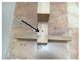
Fixer ensuite le petit limon dans le sol pour solidariser l'ensemble de l'escalier. Pour cela réalisez un repère puis faire un trou au perforateur dans le sol puis replacer le limon et visser avec une vis  $\emptyset 6 \times 200$  ou  $\emptyset 6 \times 180$
