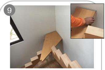
Commencez par installer la marche d'angle en laissant 15 millimètres entre le mur et la marche
