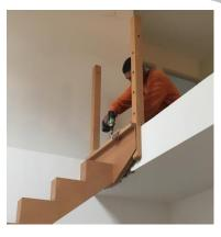
Glisser le(s) poteau(x) d'arrivée entre la dalle et la platine d'arrivée puis visser dans la dalle la première marche (3 vis)
