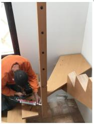
Lorsque vous arrivez au poteau d'angle : mettez de la colle PU dans les entailles du poteau, et insérer les marches ensuite dans les entailles avant le les visser comme les autres. Placez le poteau de manière à ce que les 4 gros trous soient bien positionnés pour recevoir les lisses du garde-corps.
