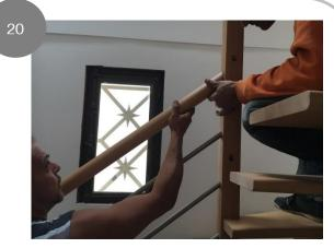
Installer les lisses en inox dans les trous du poteau central et dans les trous du poteau de départ
