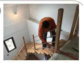
Faire de même avec le garde corps supérieur : rentrer les lisses dans les trous et installer au centre la potelet intermédiaire (repose sur la marche 9 ou 10)
