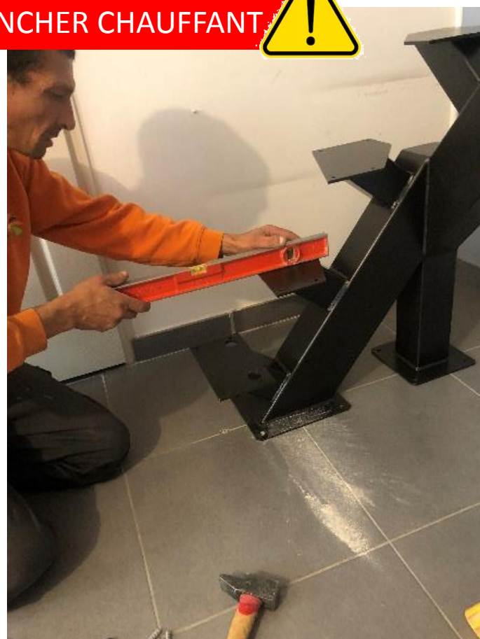
Fixer le limon au sol : percer le sol dans les trous de la platine du limon. Renouveler l'étape pour tous les trous.
