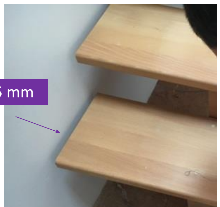
Replacer si nécessaire le limon en respectant les 15 mm entre le mur et la marche en bois.
