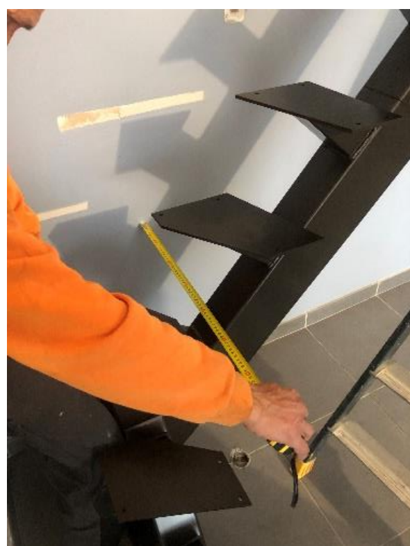
Replacer si nécessaire le limon en respectant les 15 mm entre le mur et la marche en bois.
