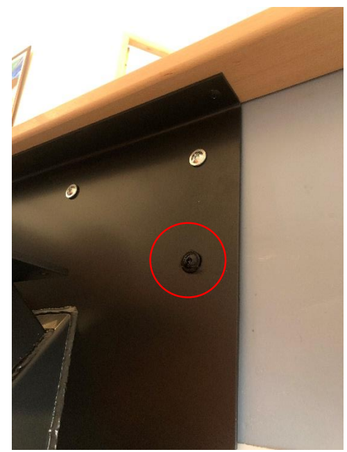
Peindre les têtes de vis avec le pot de retouche de peinture fournie.
