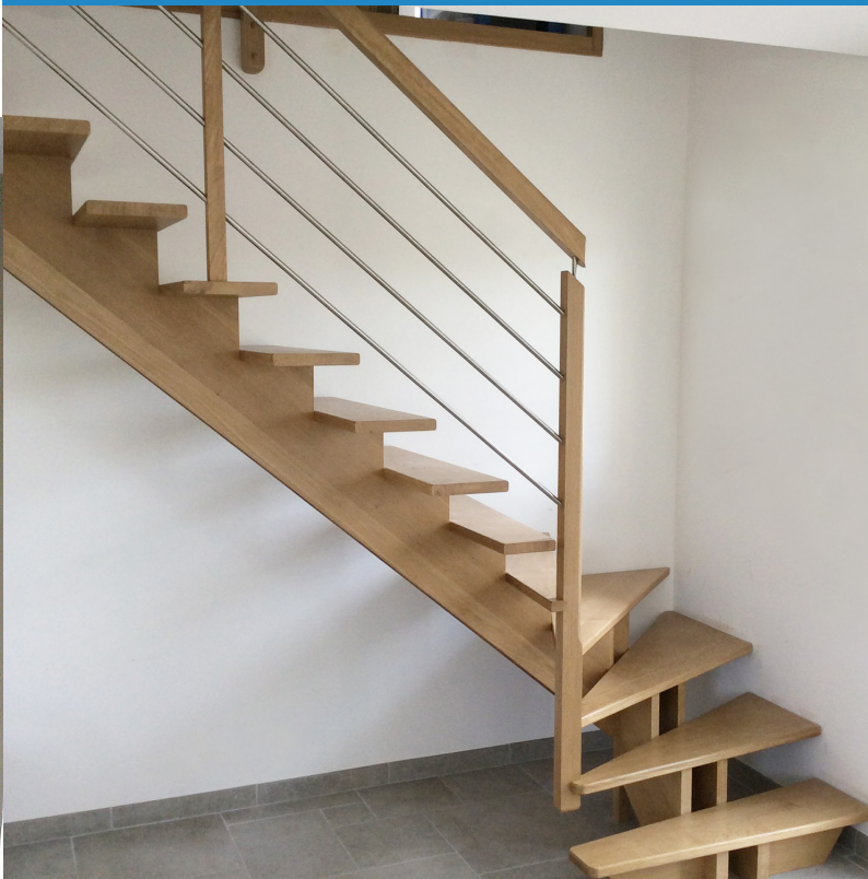
Brême PB ↑ Double crémaillères centrées Poteau bois P5 et lisses inox
