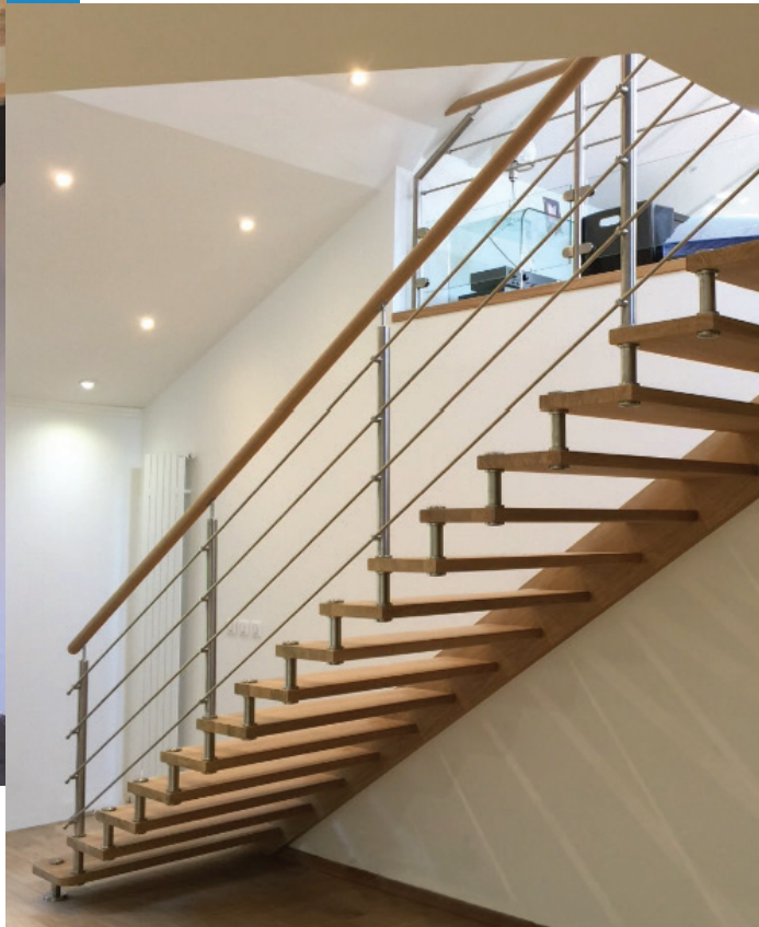
Forêt Noire Pi Entretoises en inox Poteaux en inox et lisses inox ↓
