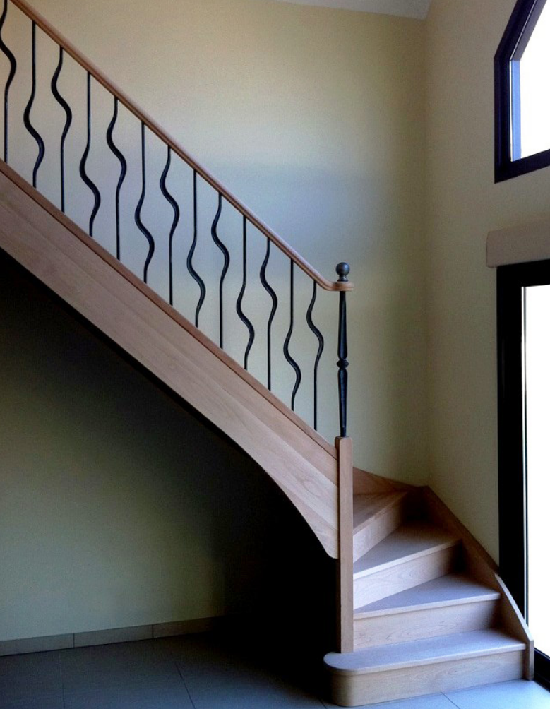
↑ Clé de sol Limon à la française Balustres en fer forgé Thermolaquage en option
