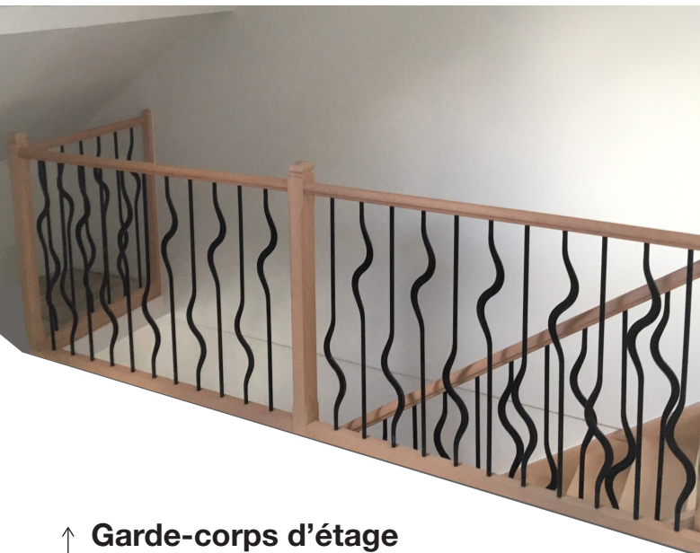
↑ Clé de sol Limon à la française Balustres en fer forgé Thermolaquage en option
