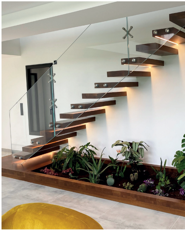
Les garde-corps rampants
