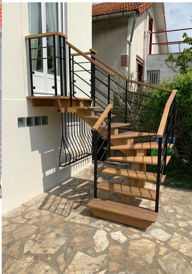
Escalier à limon central en bois iroko Poteaux acier et main-courante en bois
