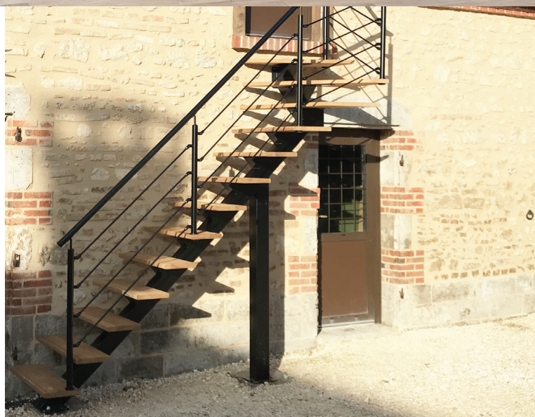
Escalier à limon central en acier Marches en bois / Chêne ou Iroko →
