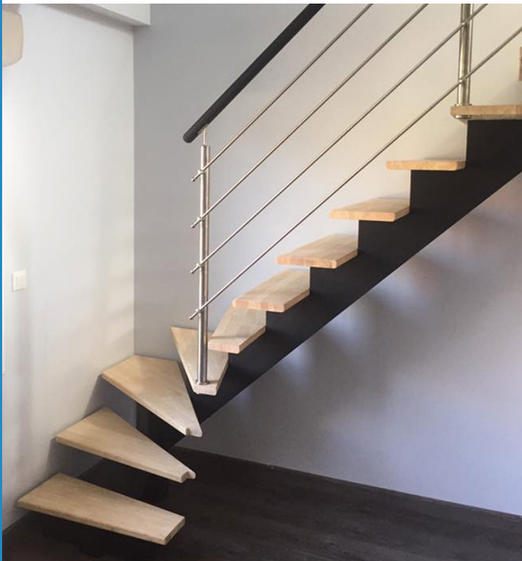
↑ Wagner Pi Crémaillère centrale en bois Poteaux et lisses inox Peinture en option
